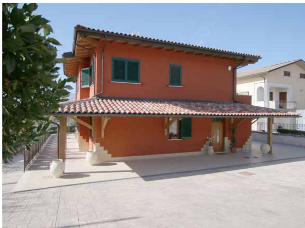
L'edificio unifamiliare è stato costruito a seguito della demolizione completa del vecchio edificio gravemente danneggiato dal sisma del 2009. È stato realizzato con una struttura portante in cemento armato con copertura in legno lamellare, solai in latero-cemento.
